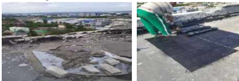
Ремонт пошкодженого даху, гуртожиток № 4.
